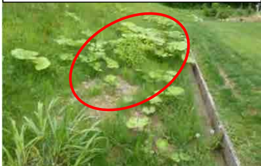
写真19: 下流法面での植生変化
