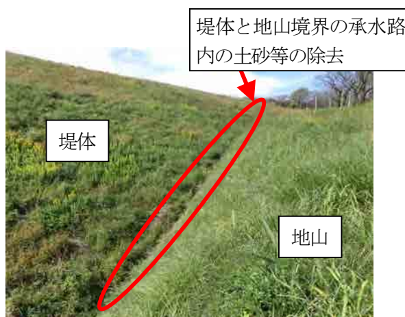
写真5：堤体と地山境界の承水路
