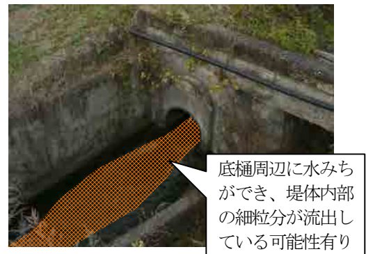
写真10：斜樋出口（堤体下流）
