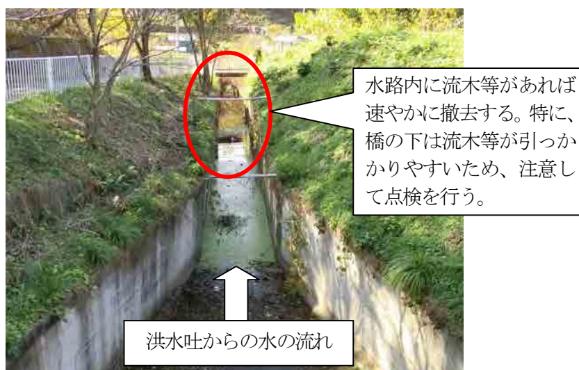
写真7: 洪水吐下流水路の例
