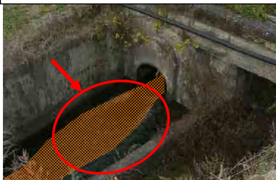
写真34:泥水の流出
