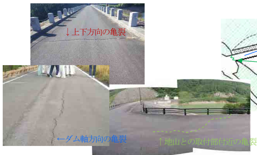
写真22：堤体天端の亀裂
