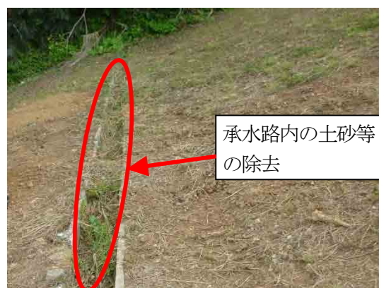
写真4：堤体下流側の承水路
