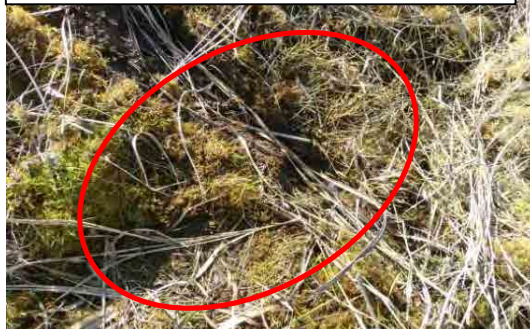
写真20: 下流法面でのコケの繁茂
