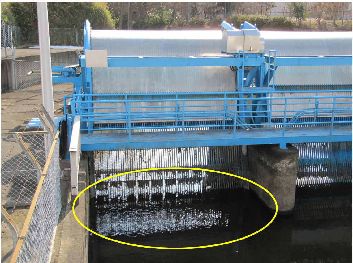
① 水没状態にあるスクリーン、受桁、フレーム等の確認
