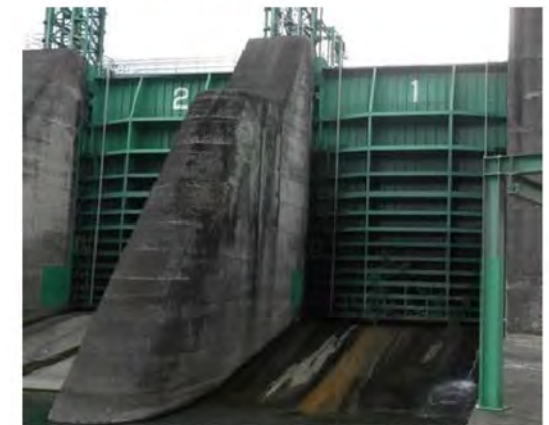
写真-1.2 堤体下流面
