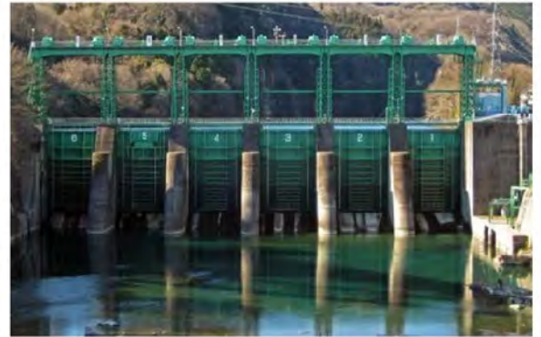
写真-1.1 堤体上流面
