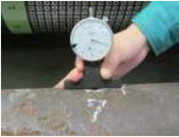
腐食深さの計測（デプスゲージによる）
