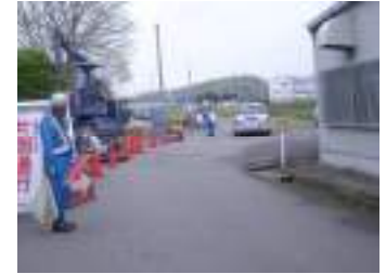
安全施設・交通誘導員の配置
