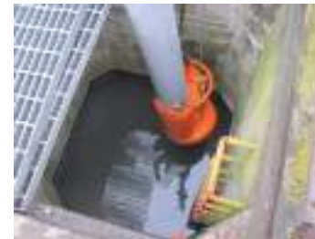
ポンプによる水替え作業
