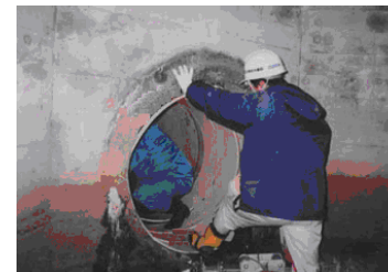
分水槽からの進入
