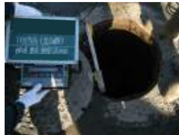
ガス検知器による事前確認
