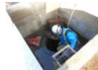
管理用人孔からの進入
