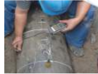
管厚計測（厚み計による）
