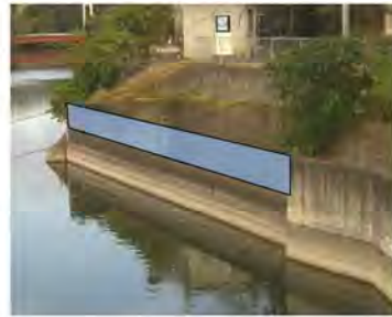
写真6: 流入工断面 （青網掛け部分）
