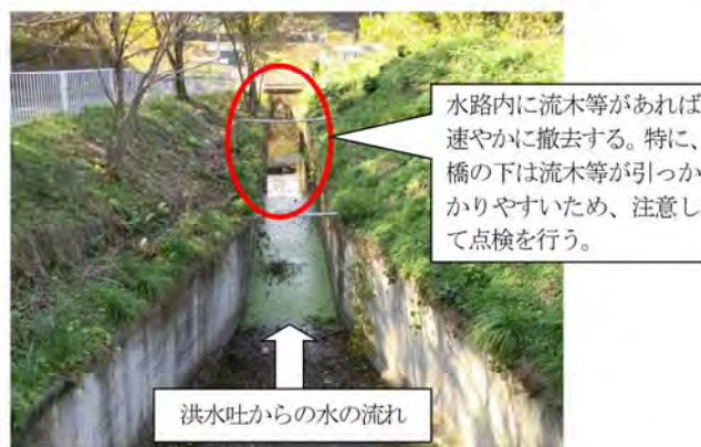
写真7: 洪水吐下流水路の例
