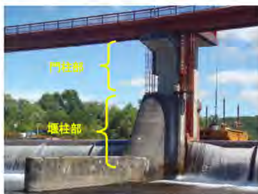
写真-2 P3堰柱
