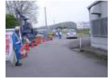
安全施設・交通誘導員の配置
