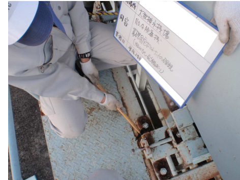
テストハンマーによる打診確認
