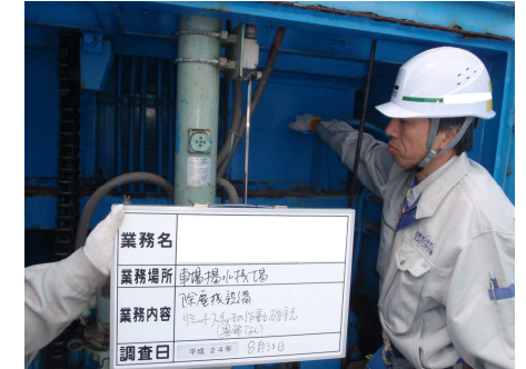
リミットスイッチ（除塵機）の動作確認
