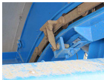
ガイドレールの調査
