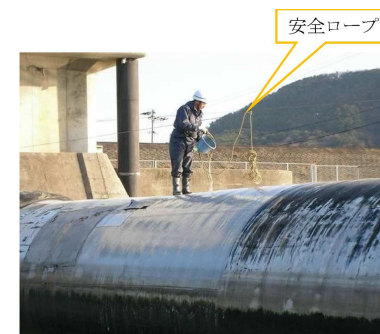
例；石鹼水散布による確認状況
