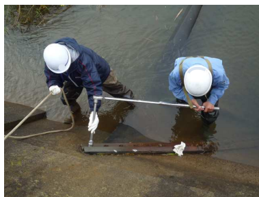
例；ボルト締めによる緩みの確認状況
