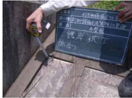
写真-3. 2. 63 周辺地盤の沈下例
