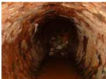
写真-3.2.23 軽微な錆が点在 写真-3.2.24 一定範囲で全体的に錆が確認
