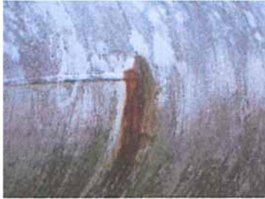
**写真-3.2.40 漏水痕跡**
