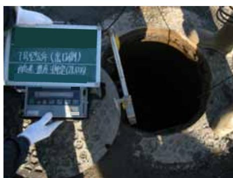
写真-3.2.16 ガス検知器による事前確認
