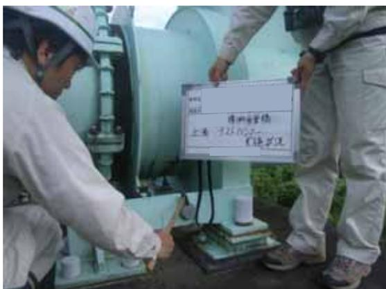
写真-3. 2. 45 伸縮継手部の診断状況
