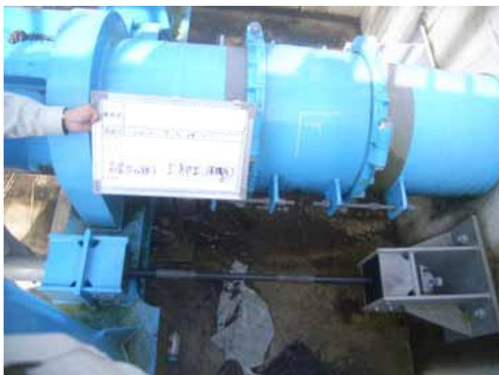
写真-3.2.47 落橋防止装置の診断状況
