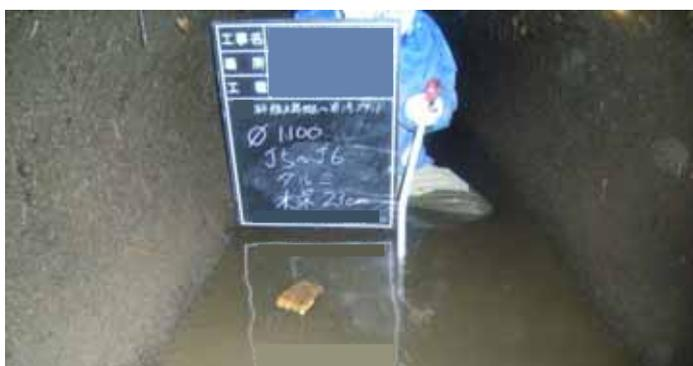
写真-3.2.26 残留水の水位測定
