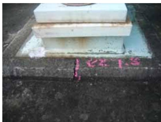
写真-3.2.44 台座のひび割れ
