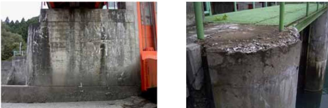
写真-3. 2. 54 凍害とASRの複合劣化
