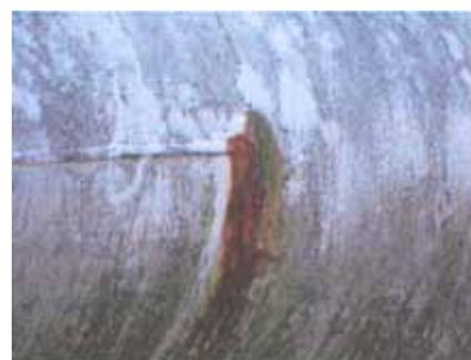
写真-3.2.39 溶接部からの漏水
