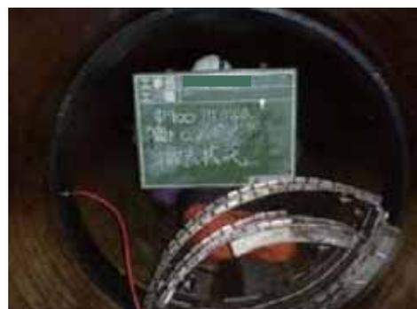
写真-3.2.31 エア式テストバンドの搬入状況
