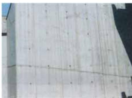
写真-3.2.49 コールドジョイントによるひび割れ
