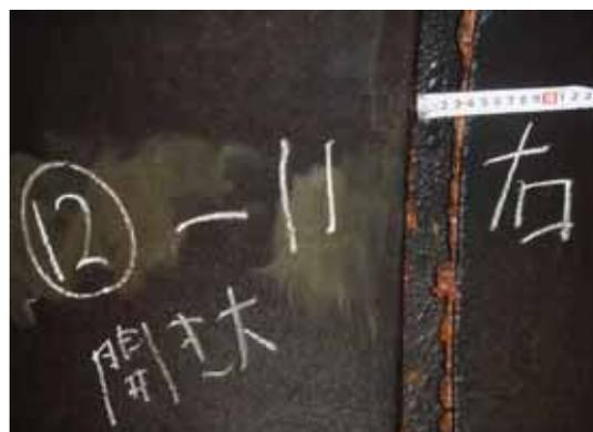
写真-3.2.28 継手の間隔の計測
