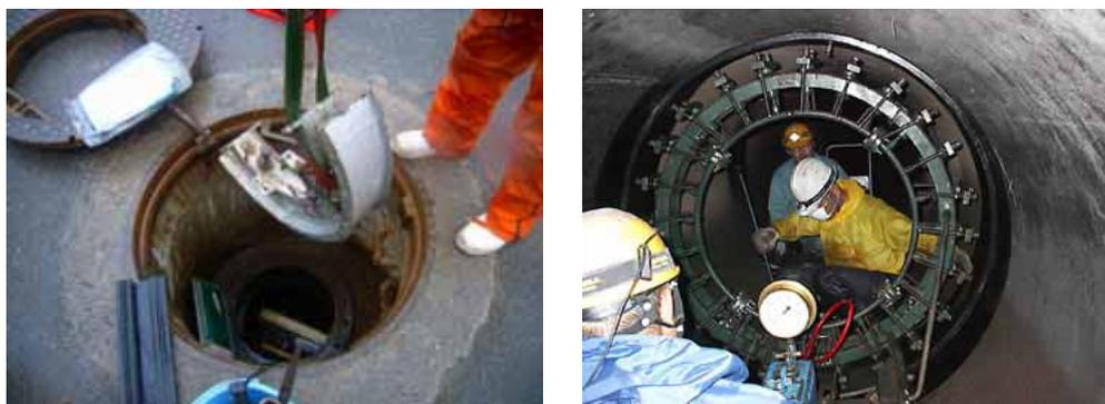
写真-3.2.30 テストバンドのセット状況
