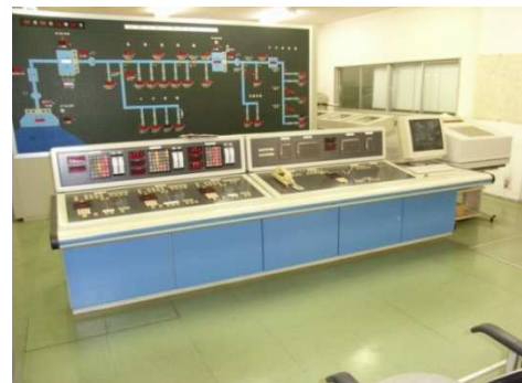
図-11.1.10 監視盤及び操作卓設置例
