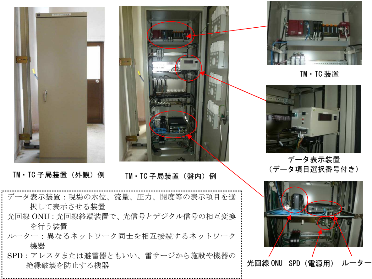
図-11.1.7 TM・TC 子局装置の主要構成装置等の例
