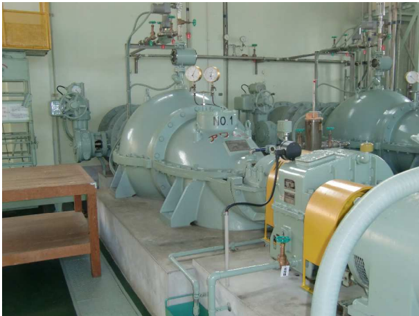
①横軸斜流ポンプの上ケーシング解放前
