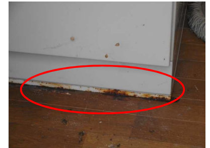
TM・TC子局装置架台の発錆
