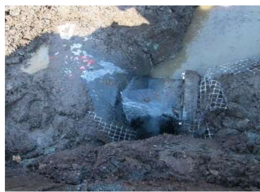
パイプラインの破損
