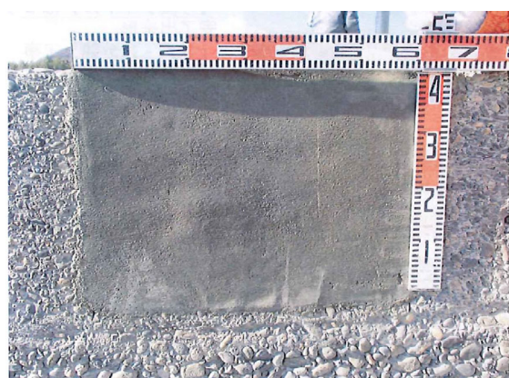
写真 4.2-56 魚道側壁天端の断面修復
