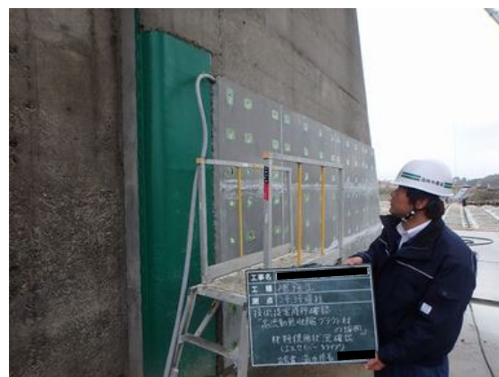
写真 4.2-16 グラウト注入状況 （堰柱下部）
