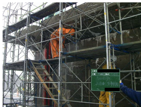
写真 4.1-6 足場の設置状況（堰柱）
