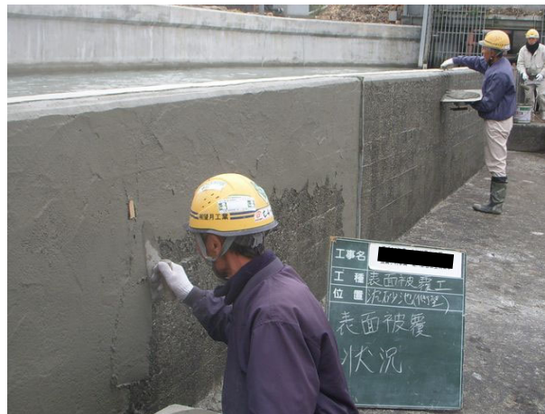
写真 4.2-76 金ゴテによる施工
