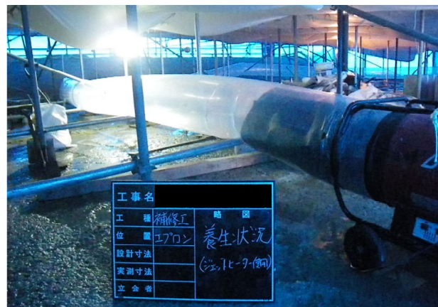
写真 4.2-46 ジェットヒータによる加温養生
