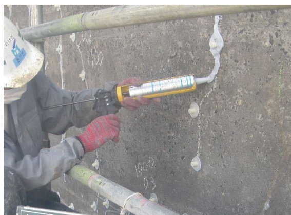
写真 4.2-52 リーク防止シールと 注入治具設置状況
