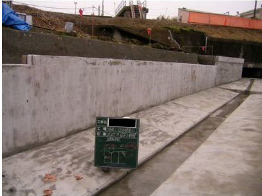
写真 4.2-78 仕上がり状況 (沈砂池全景)
