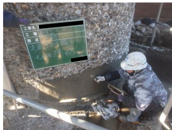
写真 4.2-12 断面修復状況 （堰柱下部）
