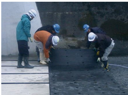
写真 4.2-19 弾性板据付状況 (エプロン)
