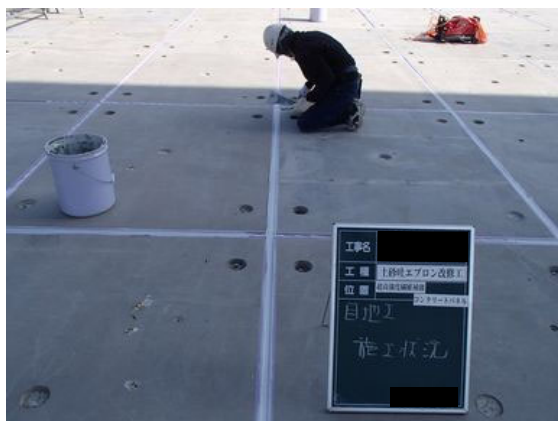
写真 4.2-5 超高強度繊維補強コンクリート パネル目地材施工状況（エプロン）
