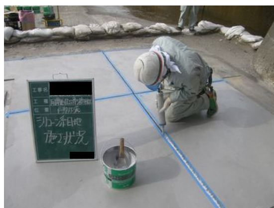
写真 4.2-51 目地材注入状況 (エプロン)
