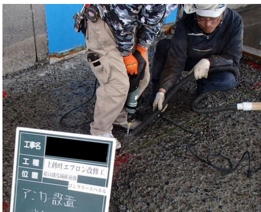
写真 4.2-1 超高強度繊維補強コンクリート パネル 削孔状況 (エプロン)
