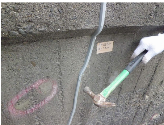
写真 4.2-68 バックアップ材の 取り付け状況
