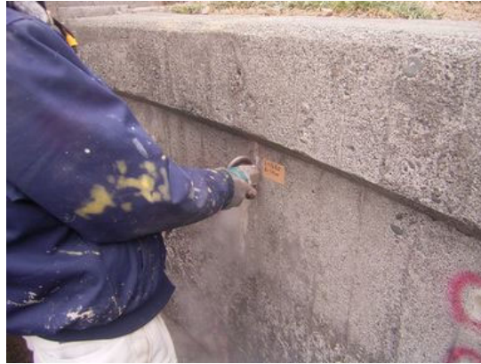
写真 4.2-66 カッター切断状況
