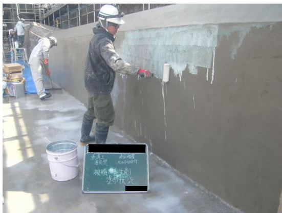
写真 4.2-60 仕上げ養生材塗布
