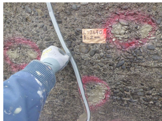
写真 4.2-69 バックアップ材の 取り付け状況
