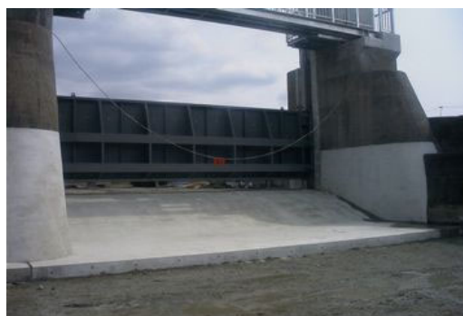
写真4.2-18 調整コンクリート 仕上げ状況 (エプロン)
