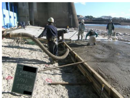
写真 4. 2-27 コンクリート打設状況 (エプロン)
