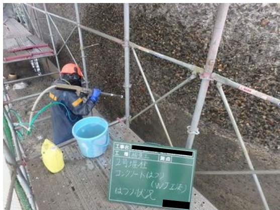
写真 4.2-9 コンクリートはつり作業状況 （堰柱下部）
