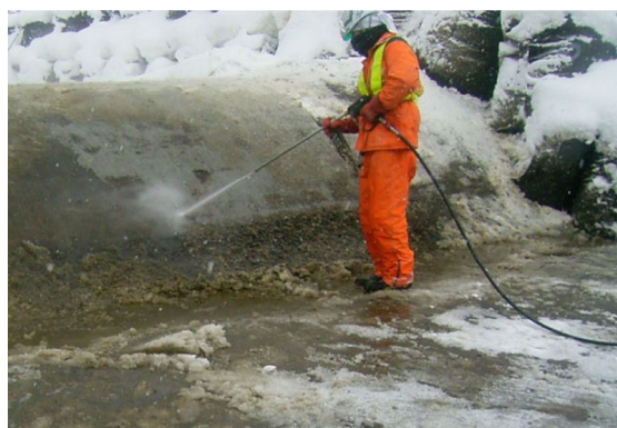
写真4.2-30 固定堰の高圧洗浄
