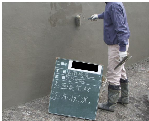
写真 4.2-77 仕上げ養生材塗布
