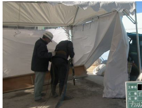
写真 4.1-12 サンドブラスト処理状況 (エプロン)
