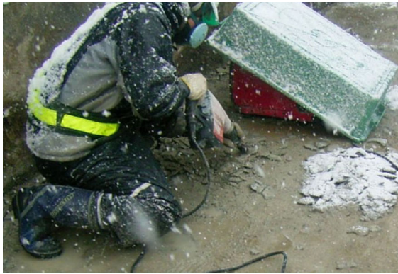
写真 4. 2-32 脆弱部の人力はつり
