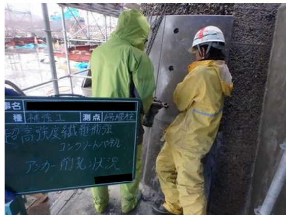
写真 4.2-14 超高強度繊維補強コンクリート パネル削孔状況（堰柱下部）
