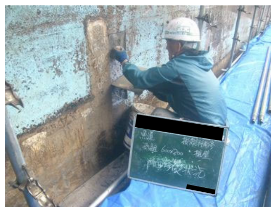
写真 4.2-55 断面修復（左官）状況
