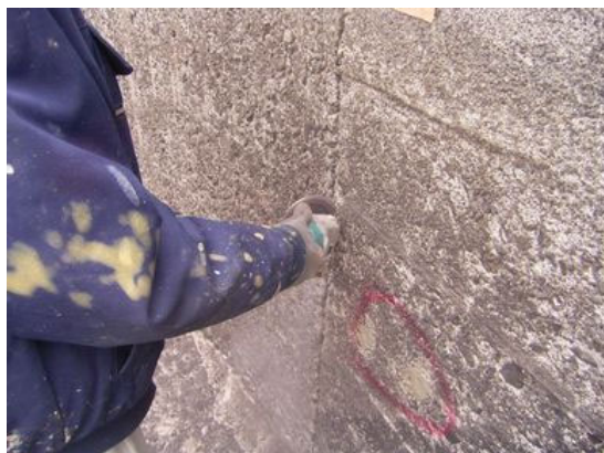
写真 4.2-72 カッター切断状況
