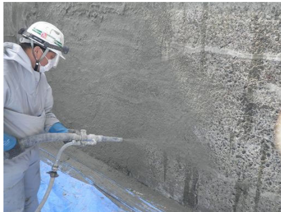
写真 4.2-59 吹付機による施工
