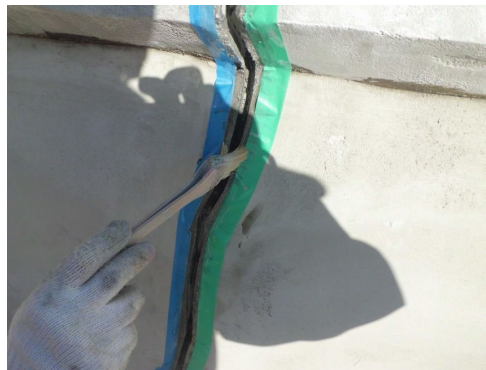
写真 4.2-67 プライマー塗布状況
