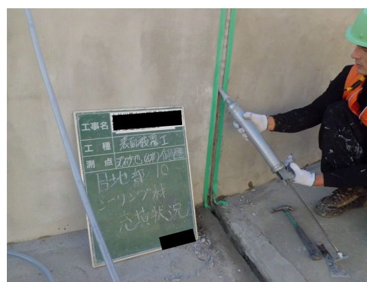
写真 4.2-73 コーキングガンによる 充填状況
