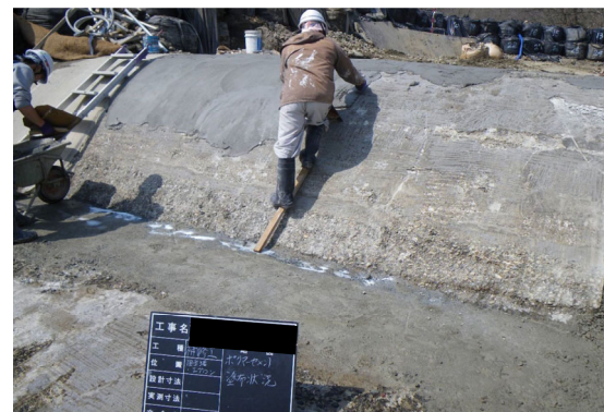
写真 4.2-43 固定堰 金ゴテによる下塗施工
