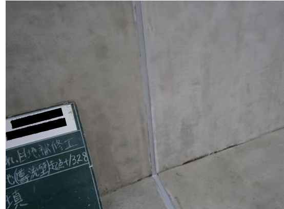
写真 4.2-79 仕上がり状況 (目地補修・表面被覆)
