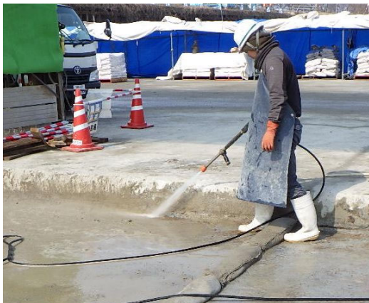
写真 4.1-11 高圧洗浄処理状況 (エプロン)
