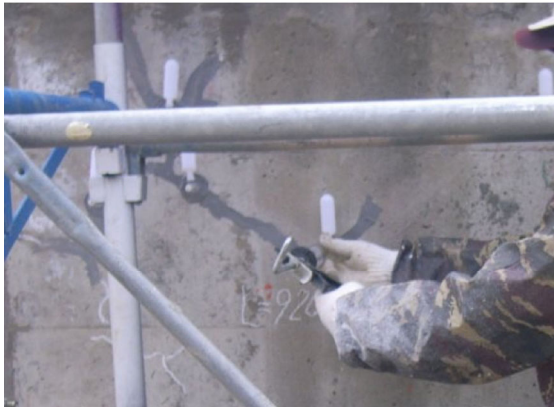
写真 4.2-38 ひび割れ注入
