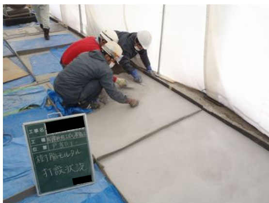
写真 4.2-50 樹脂モルタル打設状況 (エプロン)
