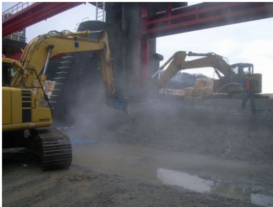
写真 4.1-9 大型ブレーカーによるはつり状況
