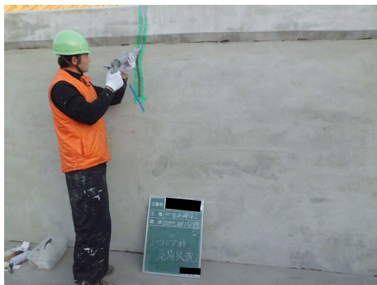
写真 4.2-70 コーキングガンによる 充填状況
