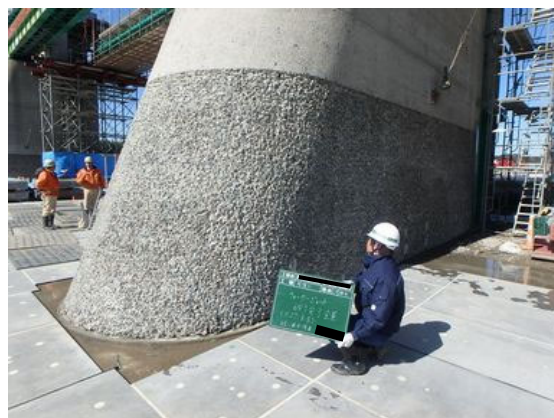
写真 4.2-10 コンクリートはつり状況 （堰柱下部）
