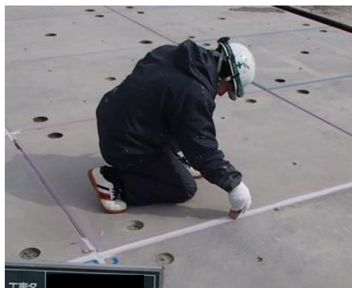
写真 4.2-6 超高強度繊維補強コンクリートパネル 目地材ヘラ仕上げ状況（エプロン）
