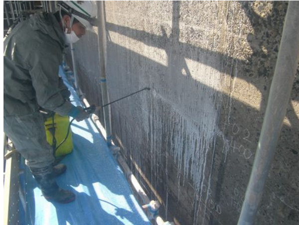
写真 4.2-58 プライマー塗布状況
