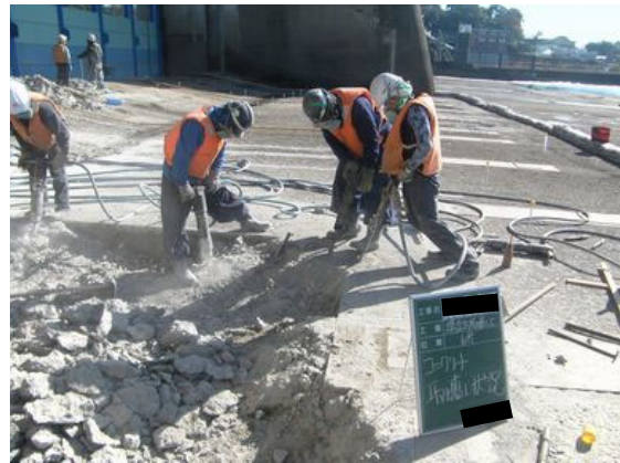
写真 4.1-10 削岩機によるはつり状況
