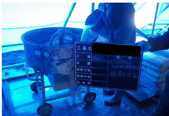
写真 4.2-42 モルタルミキサーによる混練り
