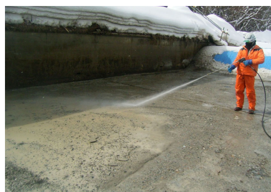
写真4.2-31 エプロンの高圧洗浄
