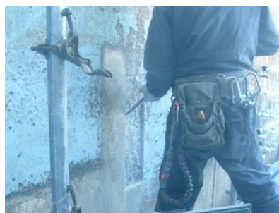
写真 2.3-24 魚道の脆弱部のはつり状況
