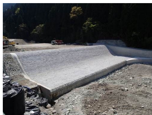
写真 2.3-15 補修後（固定堰）
