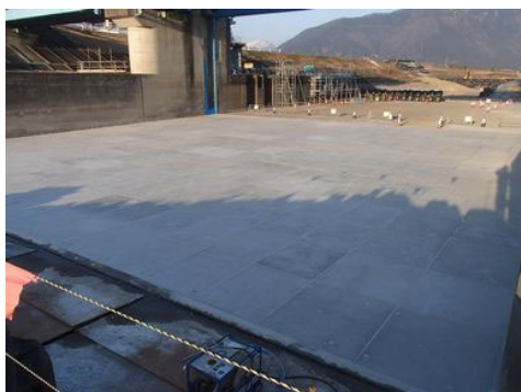
写真 2.3-3 超高強度繊維補強 コンクリートパネル工法の施工例 (OK頭首工エプロン)
