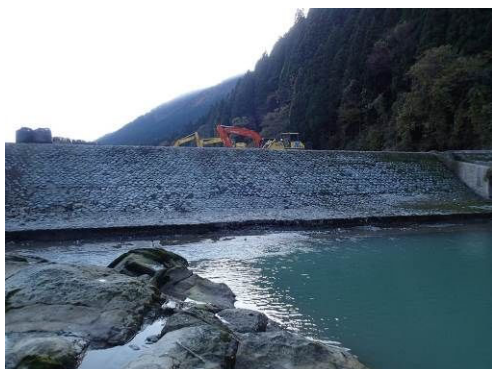
写真 2.3-14 補修前（既設固定堰）
