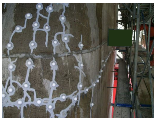
写真 2.3-19 スクイズ工法 堰柱の自動式低圧注入状況
