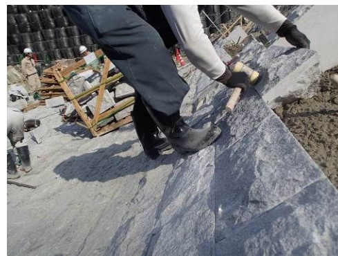
写真 2.3-17 間知石の据付
