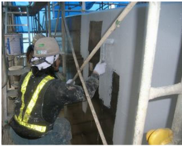
写真 2.3-10 有機系被覆工法（塗り付け型） 堰柱の施工状況
