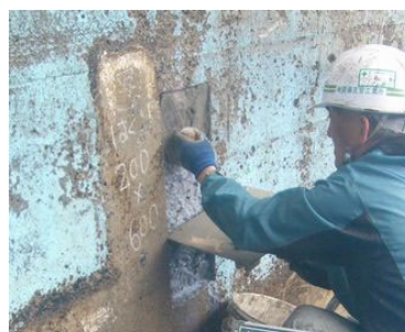
写真 2.3-25 魚道の断面修復状況
