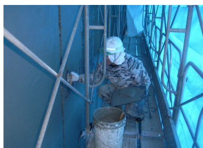
写真 2.3-1 無機系被覆工法（左官工法） 沈砂池側壁の施工状況
