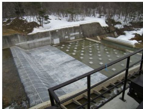
写真 2.3-4 超高強度繊維補強 コンクリートパネル工法の施工例 (G頭首工エプロン)
