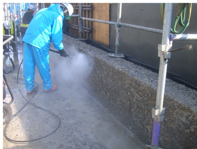
写真1.7-13 S T頭首工 土砂吐き上流エプロンの摩耗状況
