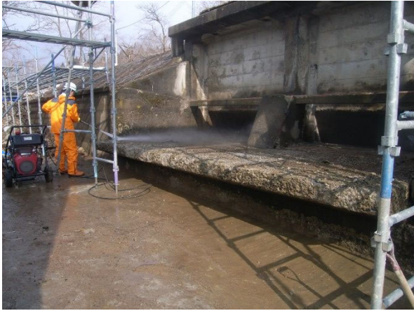
写真1.6-15 取水工の摩耗・骨材露出
