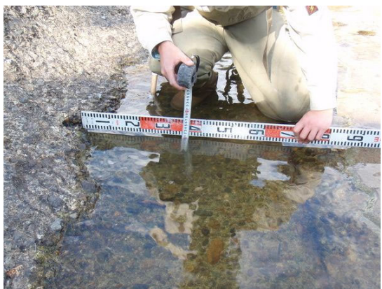
写真1.7-10 ST頭首工 固定堰下流端部の段差100mm
