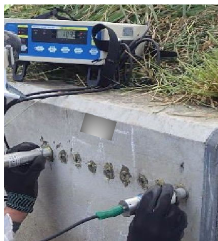
写真 6.6-1 表面走査法の現地試験
