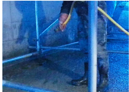
写真 4. 2-33 エアコンプレッサーによる清掃
