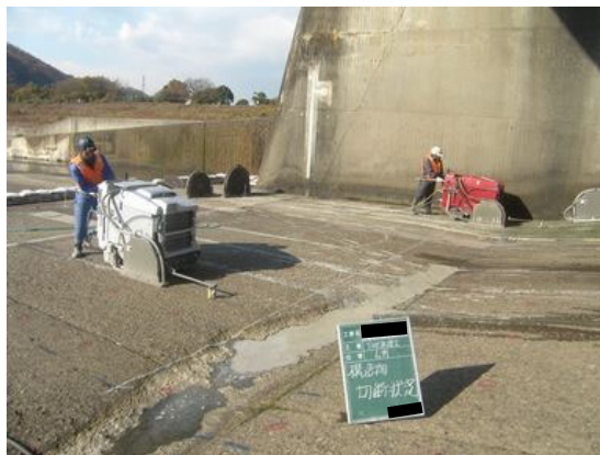
写真 4.1-8 コンクリート切断状況 (エプロン)
