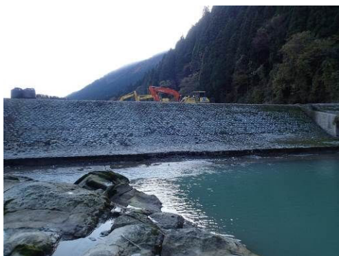
写真 2.3-14 補修前（既設固定堰）
