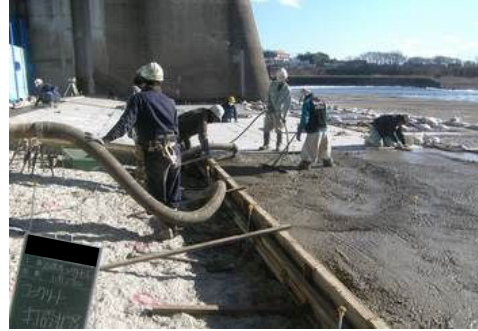
写真 2.3-27 コンクリートポンプ車打設状況 (エプロン)
