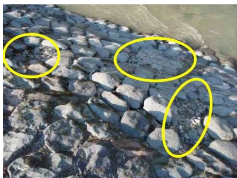
写真 2.3-13 石材剥離の補修跡（既設固定堰）
