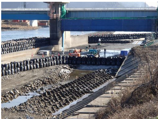
写真 4.1-1 土砂締切（大型土のう）
