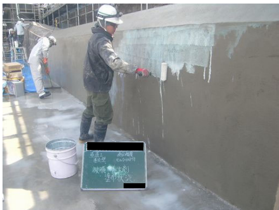
写真 4.2-60 仕上げ養生材塗布
