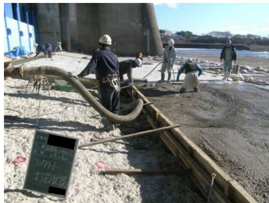
写真 4. 2-27 コンクリート打設状況 (エプロン)
