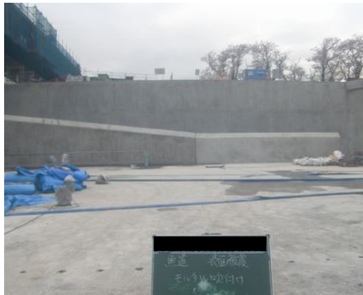
写真 4.2-62 P頭首工 魚道外側仕上げ状況
