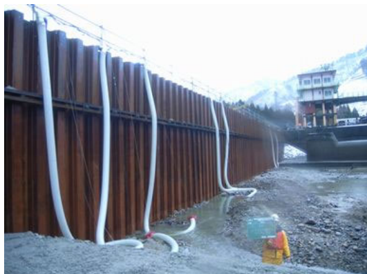
写真 4.1-3 ポンプ排水状況
