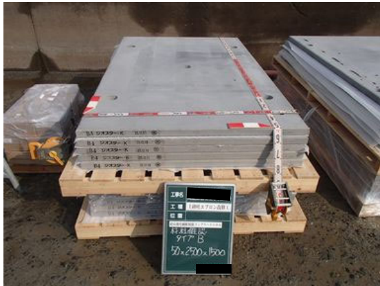
写真 5.1-1 材料検査状況例 (超高強度繊維補強コンクリートパネル)
