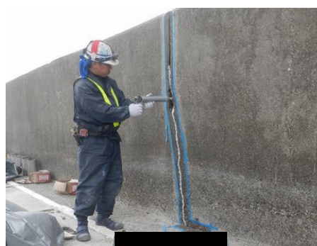
写真 2.3-23 魚道のシーリング材充填状況
