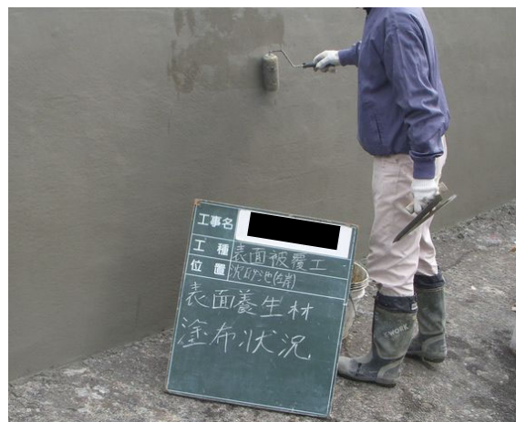
写真 4.2-77 仕上げ養生材塗布
