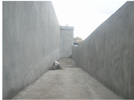
写真 4.2-63 P頭首工 魚道内側仕上げ状況
