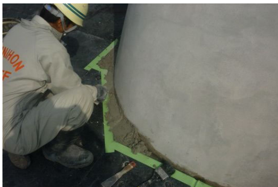
写真 4.2-23 弾性板端部仕上げ状況 （エプロン堰柱接続部）
