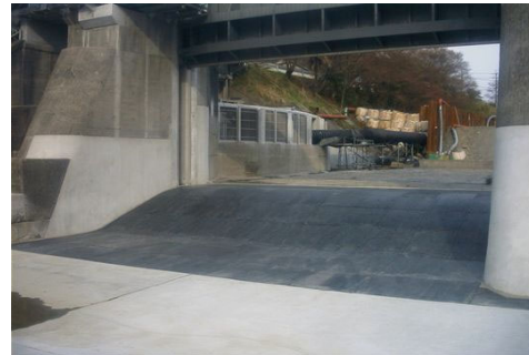
写真 2.3-5 弾性板工法の施工例 (MZ頭首エプロン)
