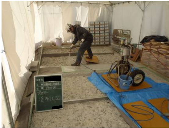
写真 4.2-47 プライマー塗布状況 (エプロン)
