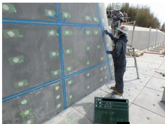
写真 4.2-15 超高強度繊維補強コンクリート パネル目地材施工（堰柱下部）
