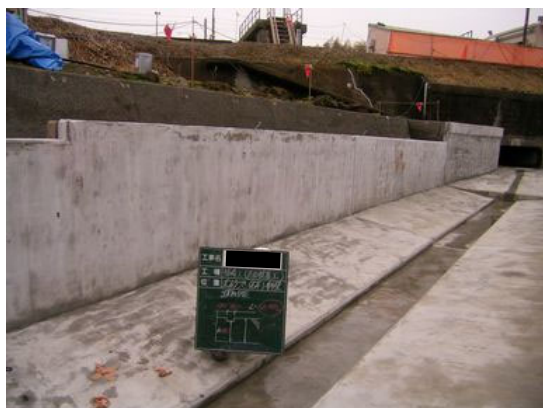
写真 4.2-78 仕上がり状況 (沈砂池全景)
