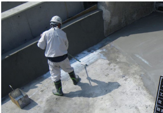
写真 4.2-40 土砂吐きエプロン プライマー塗布状況
