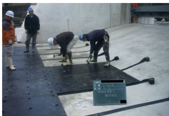
写真 4.2-20 弾性板据付状況 (エプロン)
