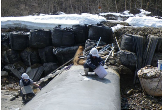
写真 4.2-44 固定堰 仕上材塗布
