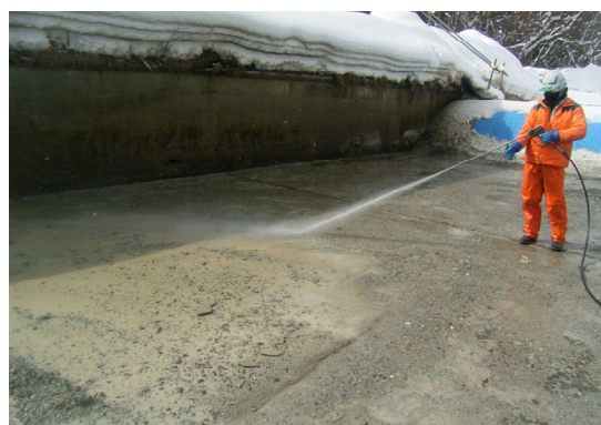
写真4.2-31 エプロンの高圧洗浄
