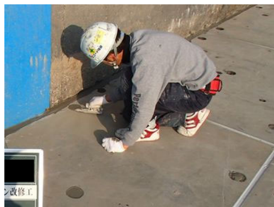
写真 4.2-4 超高強度繊維補強コンクリート 孔埋処理状況 (エプロン)
