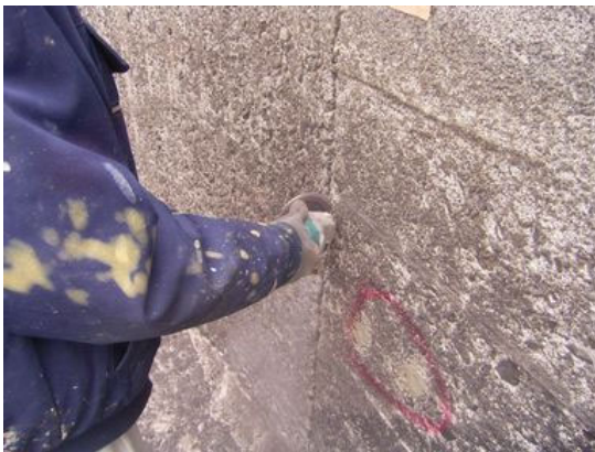
写真 4.2-72 カッター切断状況
