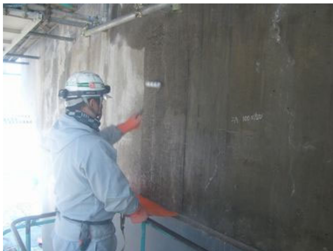
写真 2.3-28 シラン系表面含浸材 堰柱の施工状況(ローラー塗り)
