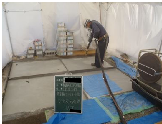
写真 4.2-49 サンドブラスト（基層面） (エプロン)
