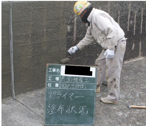
写真 4.2-74 プライマー塗布状況
