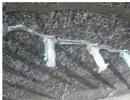
写真 4.2-53 注入用器具による注入状況
