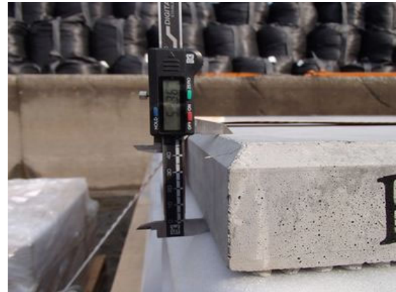
写真 5.1-2 材料検査状況例 (超高強度繊維補強コンクリートパネル)
