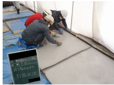
写真 2.3-11 有機系被覆工法（塗り付け型） エプロンの施工状況
