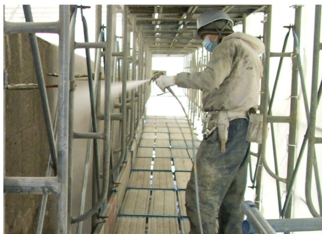
写真 2.3-29 けい酸塩系表面含浸材 堰柱の施工状況(吹付け)
