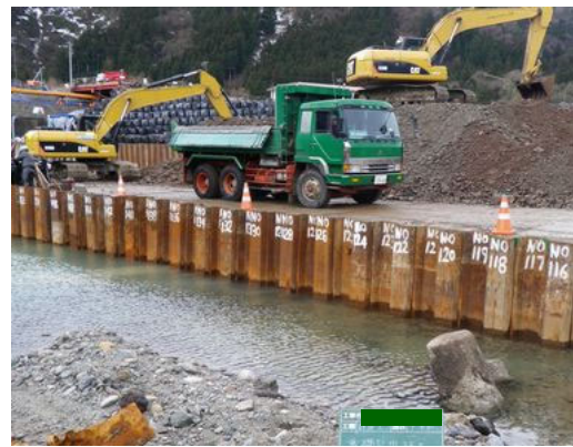
写真 4.1-2 鋼矢板締切
