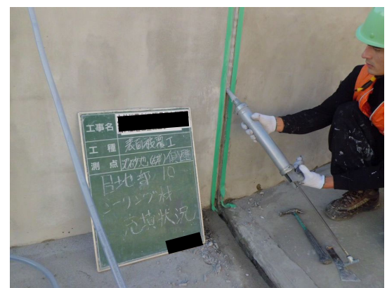
写真 4.2-73 コーキングガンによる 充填状況
