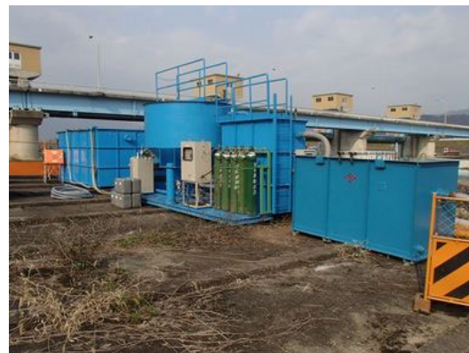
写真 4.1-4 濁水処理施設設置状況
