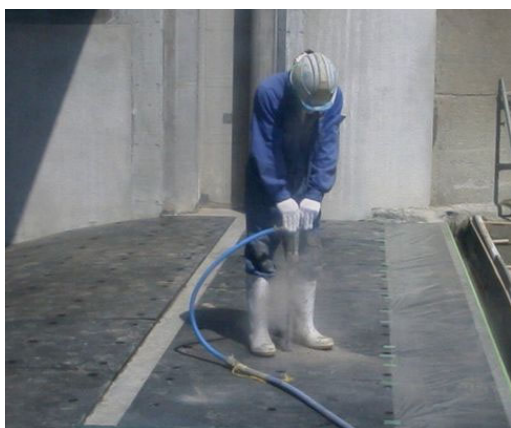
写真 4.2-21 弾性板アンカー削孔状況 (エプロン)
