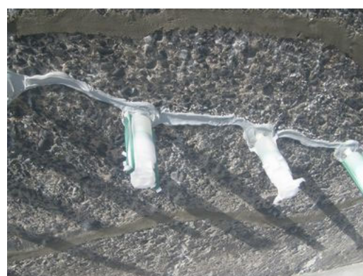
写真 2.3-21 シリンダー工法 魚道の自動式低圧注入状況
