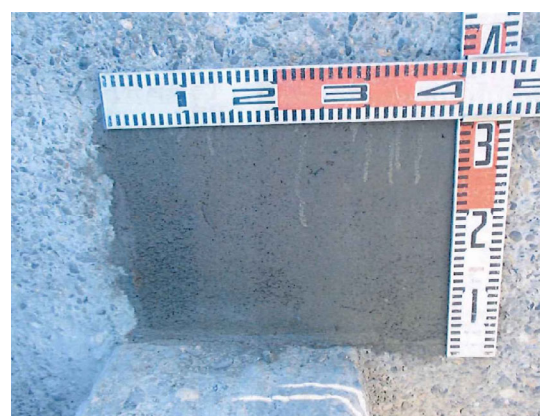
写真 4.2-57 越流部横の断面修復
