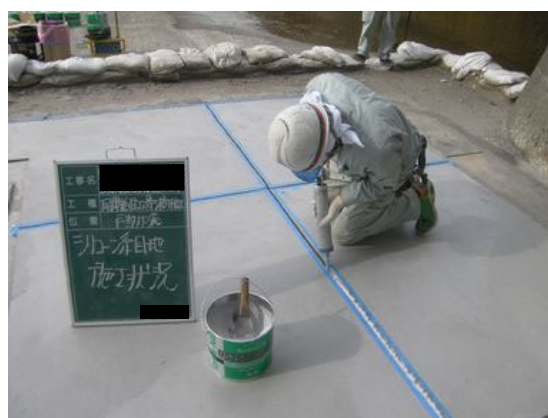
写真 4.2-51 目地材注入状況 (エプロン)
