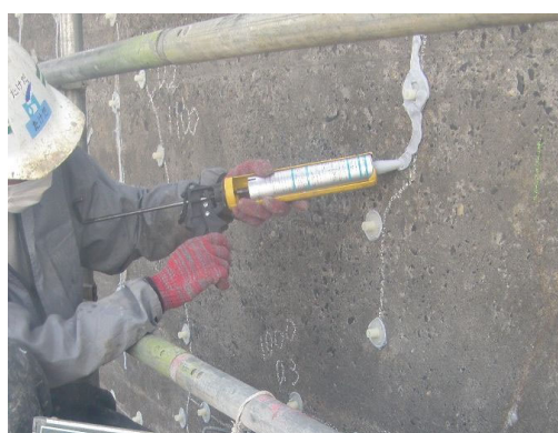
写真 2.3-20 シリンダー工法 魚道のリーク防止シール・注入治具設置状況
