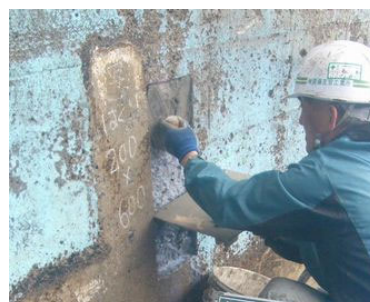
写真 2.3-25 魚道の断面修復状況
