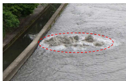
写真 6.1-2 堰下流側（変状拡大）
