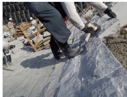
写真 2.3-17 間知石の据付
