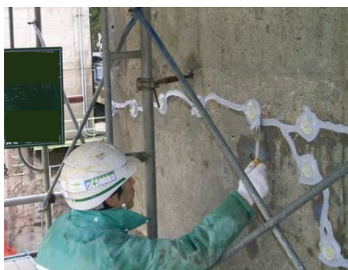
写真 2.3-18 スクイズ工法 堰柱のリーク防止シール・注入治具設置状況
