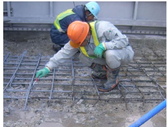
写真 4. 2-35 土砂吐き下流エプロン 鉄筋防錆処理
