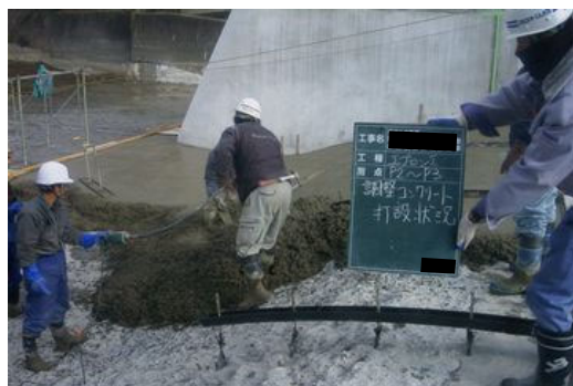
写真4.2-17 調整コンクリート 打設状況 (エプロン)
