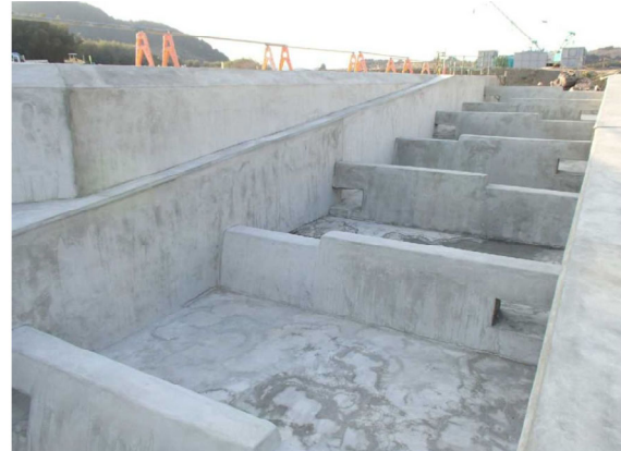
写真 4.2-65 G頭首工 仕上げ状況 (下流側からの写真)
