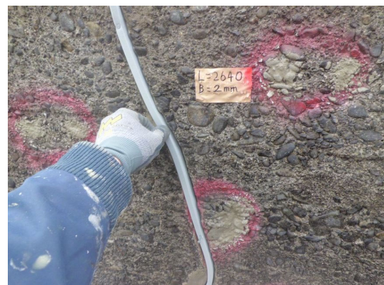
写真 4.2-69 バックアップ材の 取り付け状況
