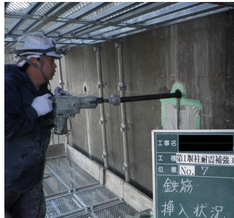
写真 2.4-3 あと施工せん断補強工法 堰柱の補強筋挿入状況
