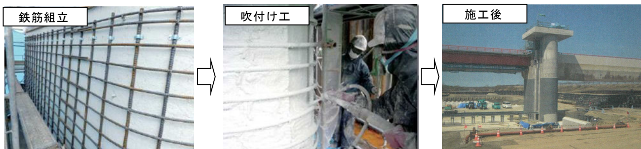
写真 2.4-1 増厚工法 堰柱の耐震補強工事の施工例
