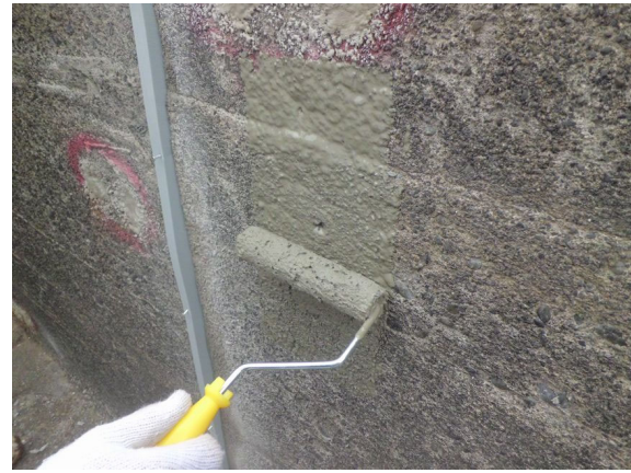
写真 4.2-75 プライマー塗布状況
