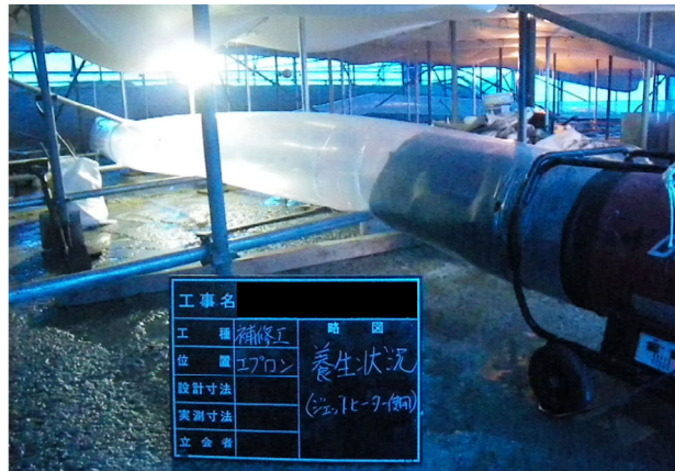
写真 4.2-46 ジェットヒータによる加温養生
