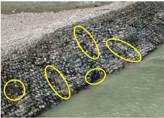
写真1.7-21 H頭首工 固定堰 補修状況
