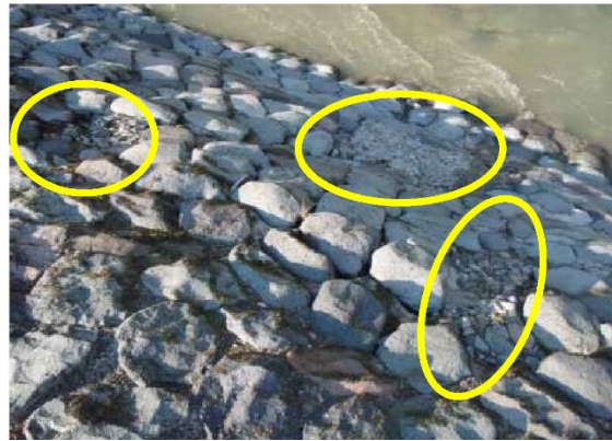
写真1.7-22 H頭首工 固定堰 補修箇所
