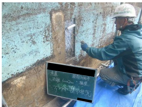
写真 4.2-54 プライマー塗布状況
