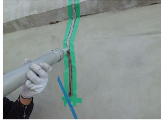
写真 4.2-71 コーキングガンによる 充填状況（拡大）
