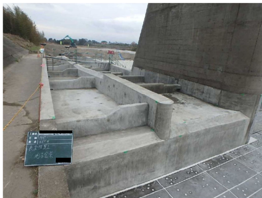
写真 4.2-64 G頭首工 仕上げ状況 (上流側からの写真)
