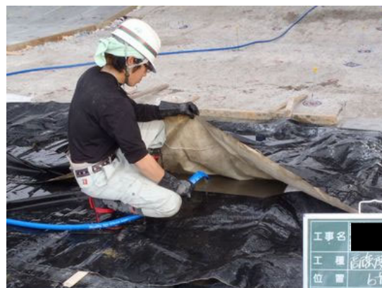
写真 4. 2-29 コンクリート散水養生状況 (エプロン)
