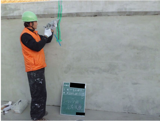
写真 4.2-70 コーキングガンによる 充填状況
