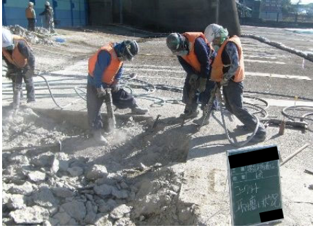
写真 2.3-26 既設コンクリートはつり状況 (エプロン)
