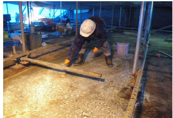
写真 4.2-41 洪水吐きエプロン プライマー塗布状況
