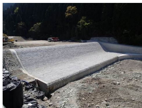
写真 2.3-15 補修後（固定堰）
