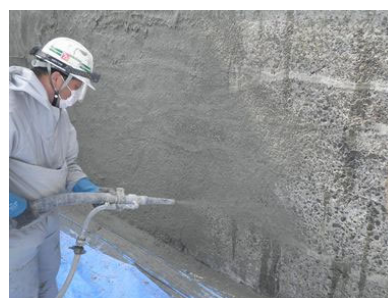
写真 2.3-2 無機系被覆工法（吹き付け工法） 導流壁の施工状況
