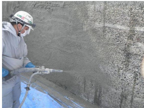
写真 4.2-59 吹付機による施工
