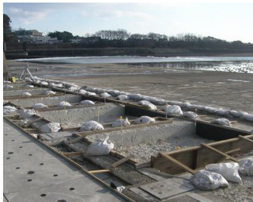
写真 4. 2-25 型枠設置状況 (エプロン)
