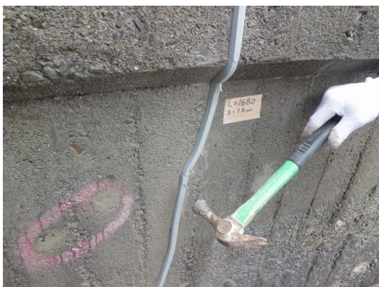
写真 4.2-68 バックアップ材の 取り付け状況
