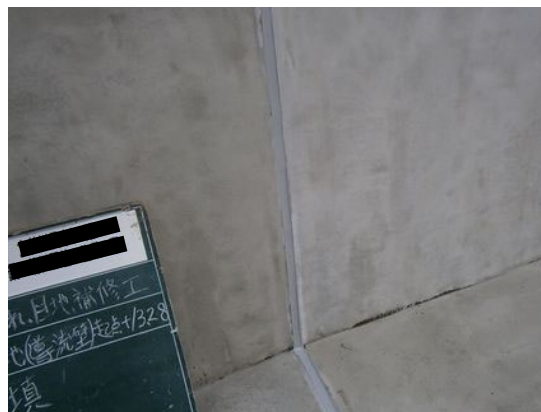
写真 4.2-79 仕上がり状況 (目地補修・表面被覆)
