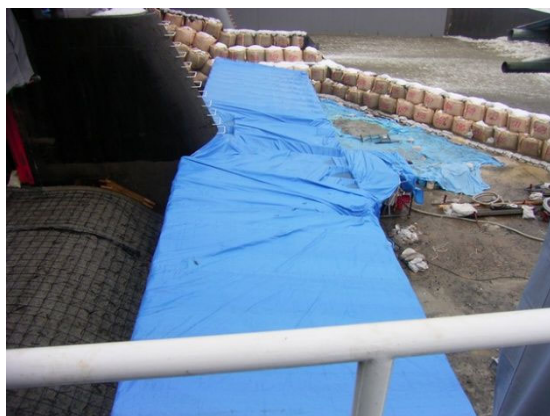
写真 4. 2-28 コンクリート養生状況 (エプロン)
