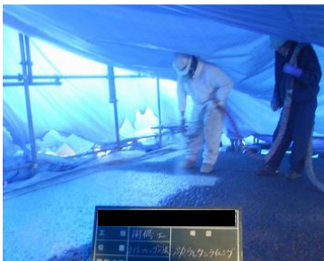
写真 2.3-12 有機系被覆工法（吹付け型） エプロンの施工状況
