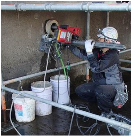
写真 2.4-2 あと施工せん断補強工法 堰柱の挿入孔の削孔状況
