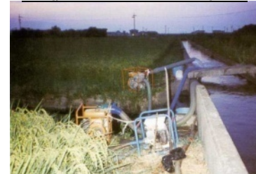
（排水路から汲み上げて再利用）
