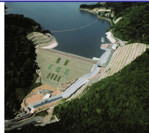
【平成13年完成の山王海ダム】
