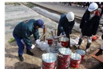
防災協力井戸の設置
