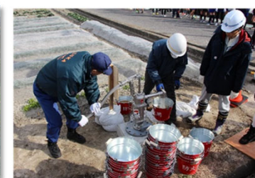
防災協力井戸の設置
