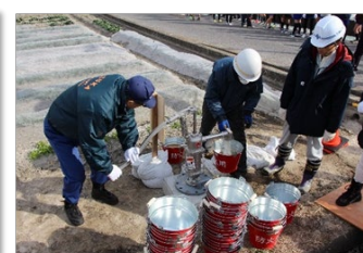
防災協力井戸の設置
