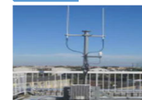
通信施設の整備
