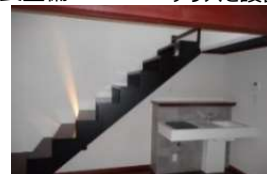
洗面台の増設
