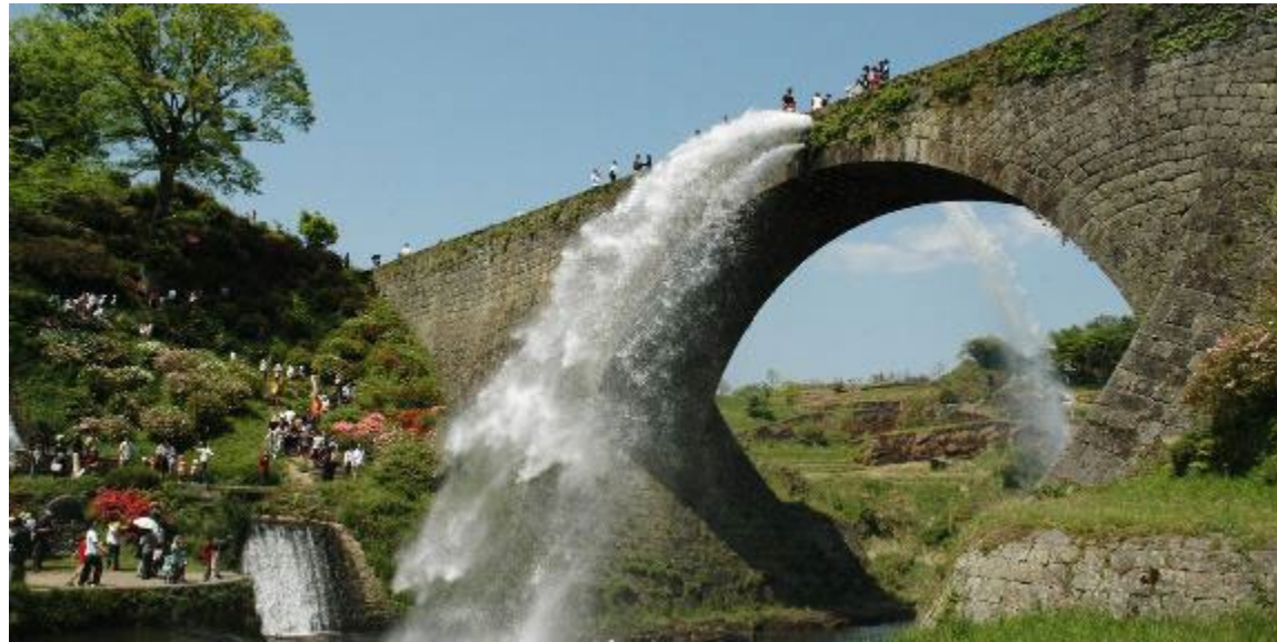
石工たちによる見事な石造りの通潤橋
