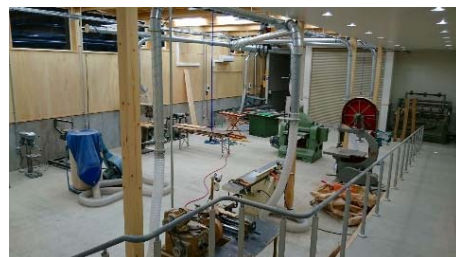
機械加工室の整備
