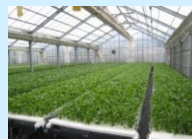
農業生産施設（水耕栽培ハウス）
