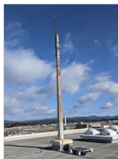
市役所屋上(公共施設)
