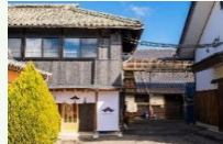
遊休施設を活用した滞在施設の整備
