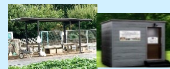
休憩所、トイレの整備
