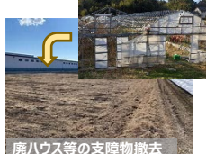
【荒廃農地の支障物撤去】
