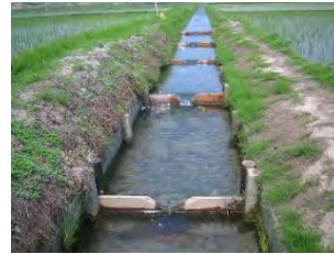
堰上式水田魚道
