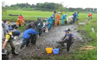
保全池の維持管理（泥上げ）
