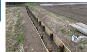
環境配慮工法（板柵）で改修した水路
