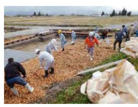
ビオトープの ウッドチップ敷設作業
