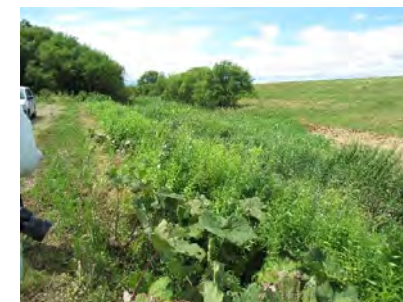
新千代北排水路の回避区間
