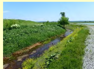
新千代北排水路の回避区間
