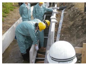
水田魚道設置作業
