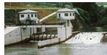
高松堰頭首工 (自然石 (粗石付き) 方式魚道)
