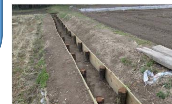
環境配慮工法（板柵）で改修した水路
