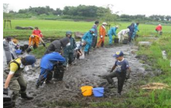
保全池の維持管理（泥上げ）
