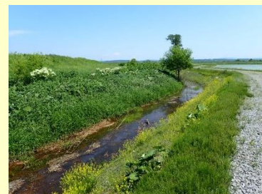
新千代北排水路の回避区間
