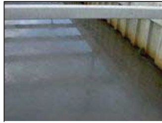
環境用水通水前 (濁り)
