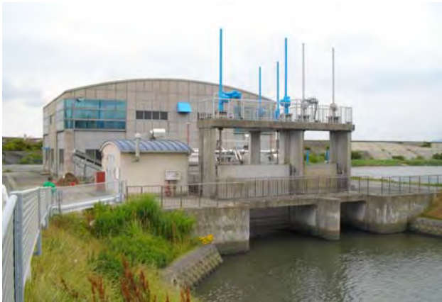
二十間川排水機場
