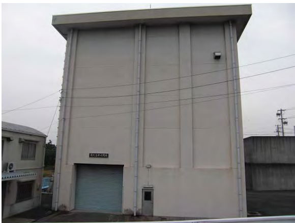
新大島排水機場
