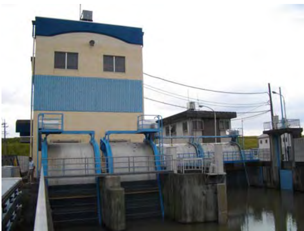
大垣東北部排水機場（吐出）
