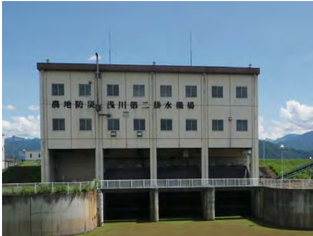
浅川排水機場
