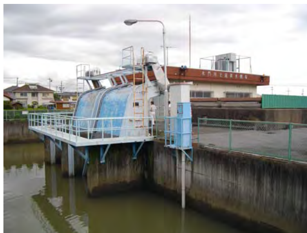
水門川上流排水機場（外観）
