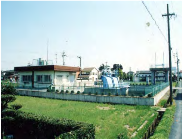
水門川上流排水機場（取水）
