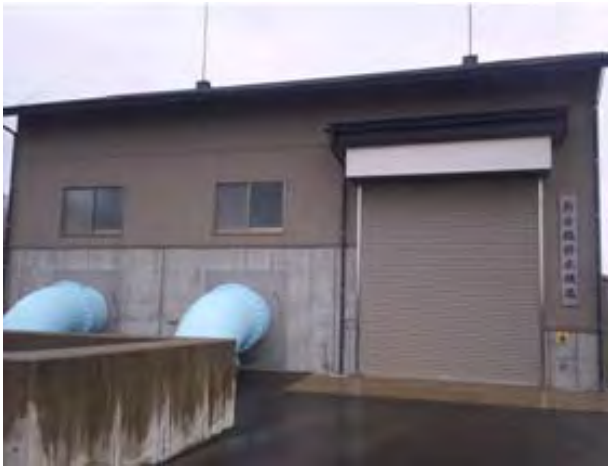
新舟橋排水機
