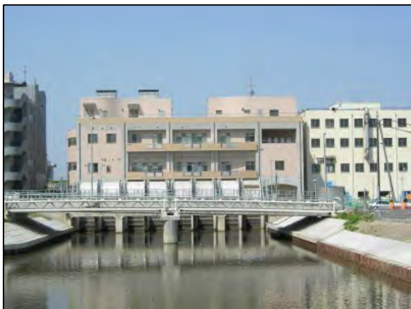
親松排水機場
