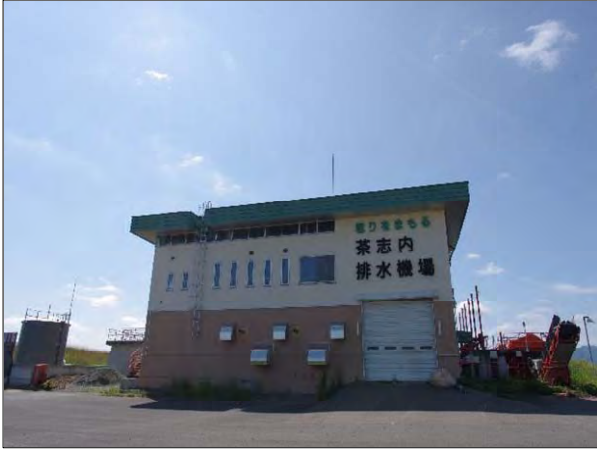
茶志内排水機場
