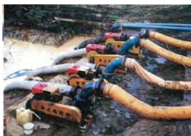
応急排水ポンプの設置状況 (甲田揚排水機場)
