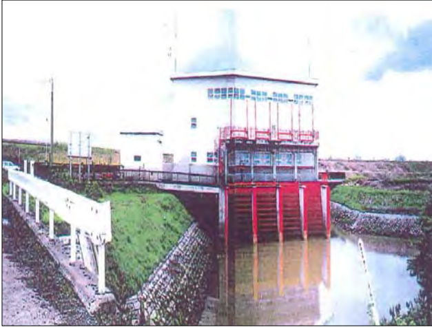
金子排水機場
