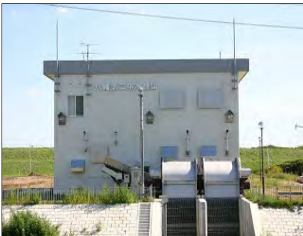
八幡第2排水機場
