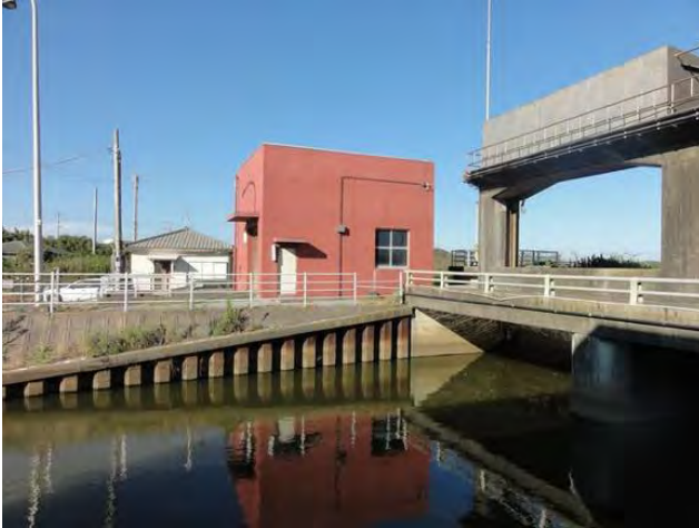
大布川常時排水機場
