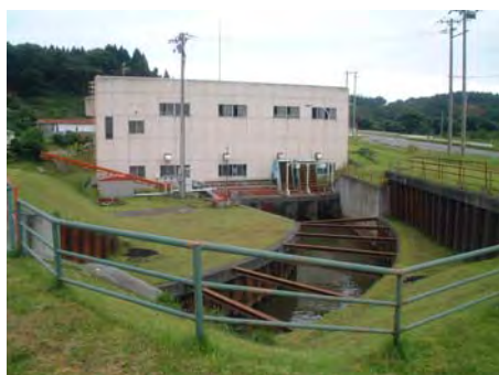
甲田揚排水機場
