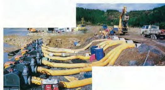
応急排水ポンプの稼働状況 (入沼排水機場)
