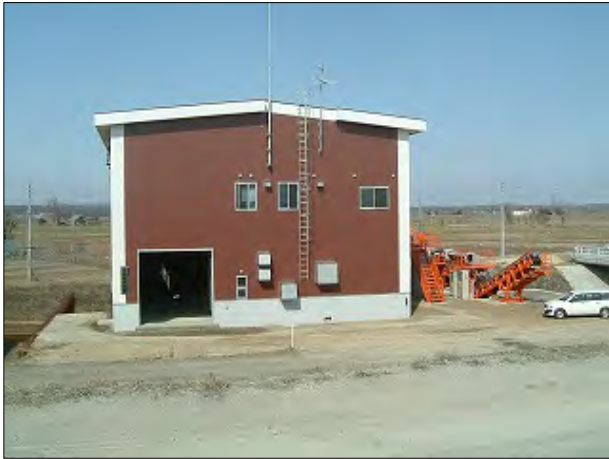
太美排水機場
