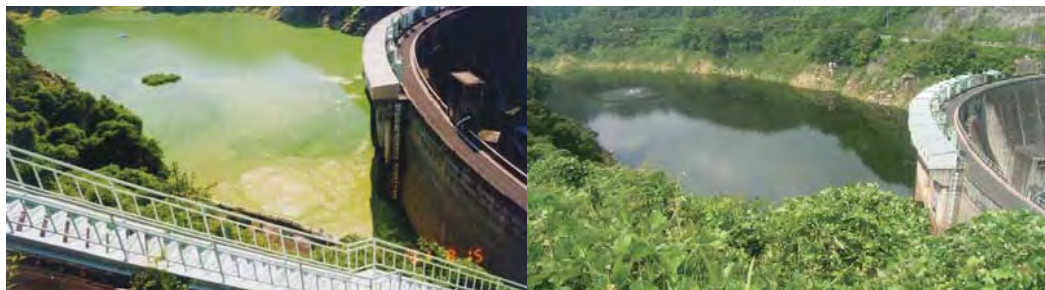
高山ダム貯水施設状況
