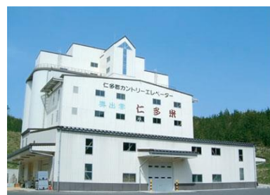
仁多米カントリーエレベーター
