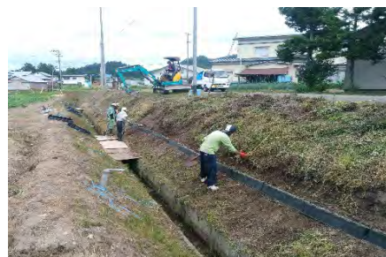
仮設階段設置 （資源向上活動 直営施工）
