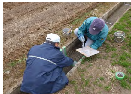
水路の漏水補修 （資源向上活動 直営施工）
