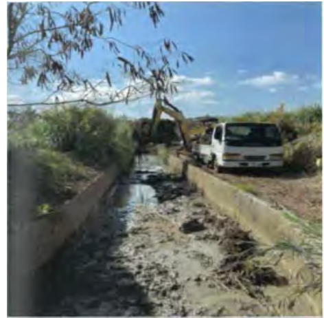
水路の泥上げ状況写真
