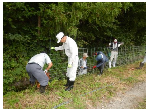
鳥獣害対策のフェンス設置
