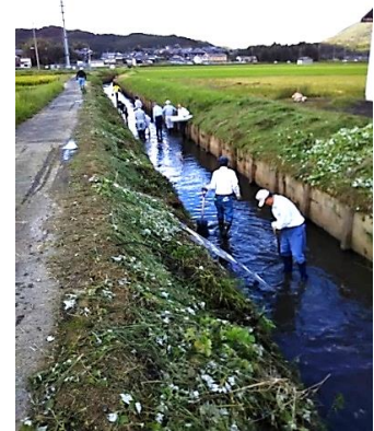
泥上げ作業の様子
