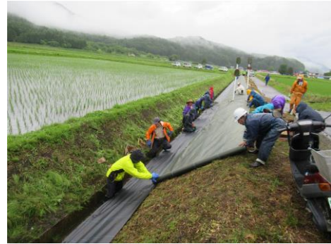
防草・抑草シートの敷設
