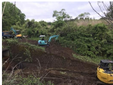
沈砂池土砂搬出
