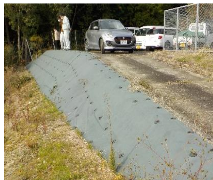
農道法面を防草シートで補強
