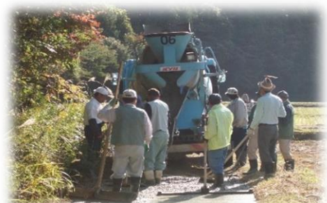
直営施工による農道整備
