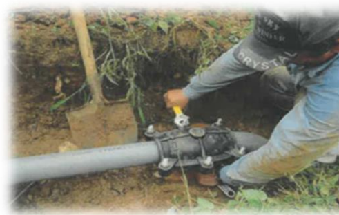
パイプラインの補修
