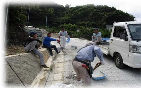
農道の路面舗装
