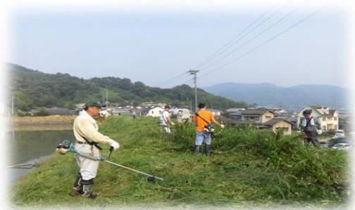
急斜面のため池堤体の草刈り
