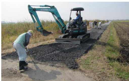
技術員による農道碎石施工
