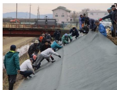
活動の様子（防草シートの敷設）
