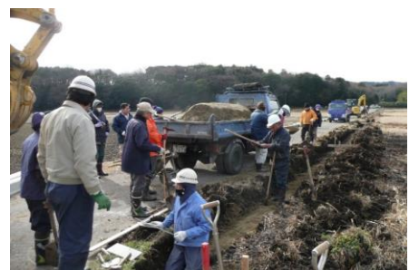
用水路の改修
