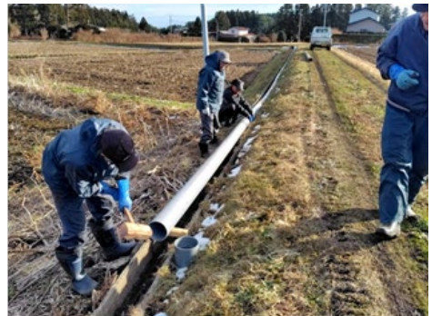
老朽化した水路の補修の様子
