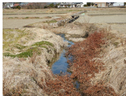
地域内の土水路
